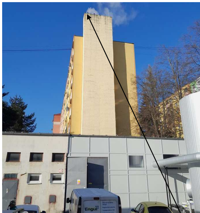
Obrázok č. 2 Komín so samostatným vyvložkovaným priechodom pre odvedenie spalín z KGJ, ostatné priechody pre plynové kotly
