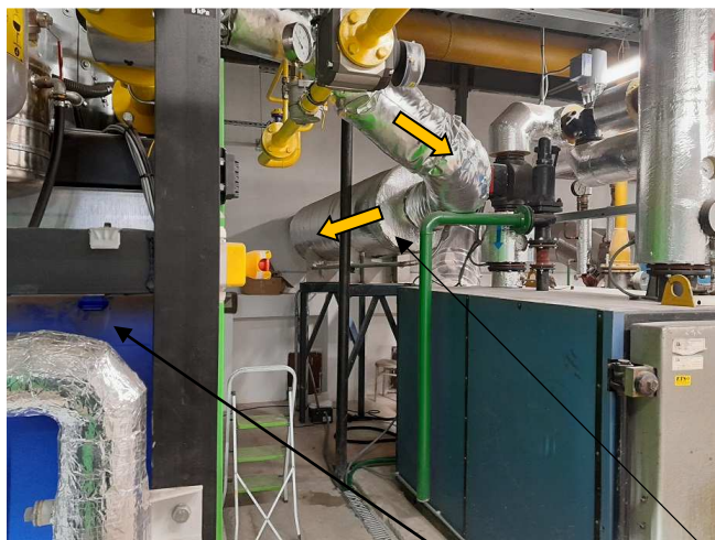
Obrázok č. 3 Kogeneračná jednotka (KGJ) a spalínovod smer prúdenia spalín
